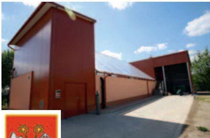
Nowoczesna oczyszczalnia ścieków w Szczurowej
