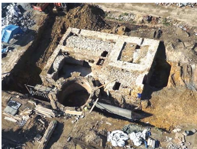
Prace zabezpieczające wokół piwnic ratusza
