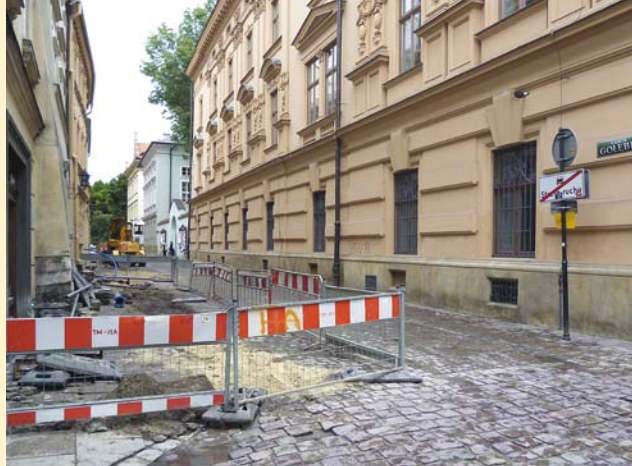
Prace przyłączeniowe do miejskiej sieci ciepłowniczej przy ul. Gołębiej w Krakowie
