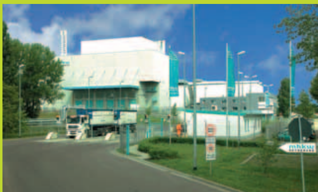
Spalarnia odpadów komunalnych MHKW Rothensee w Magdeburgu. Fot. Jacek Balcewicz
