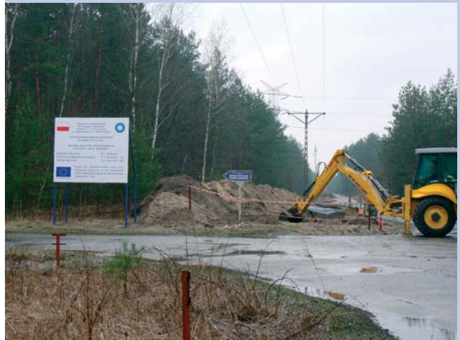
Rozpoczęcie robót przy realizacji magistrali zbiornik Libiąż-Chrzanów przy GOŚ „Chrzanów”.
