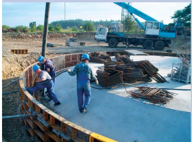
Wykonanie fundamentów jednego z dwóch realizowanych zbiorników wody w Chrzanowie.
