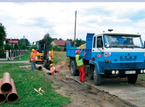
Wykonawca zadania „Budowa kanalizacji w Gminie Trzebinia” po zasypaniu i utwardzeniu wykopów przywraca drogę do stanu pierwotnego. Zadanie realizuje firma „WAFRO” Sp. z o.o. z Brzozowa.
