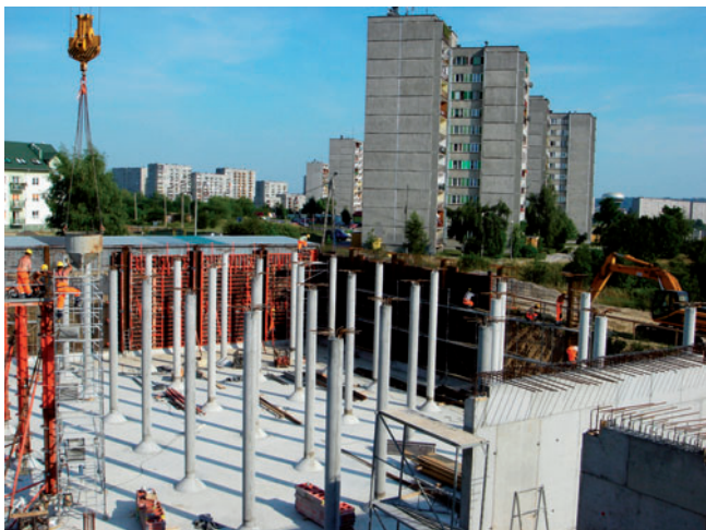
Nowy zbiornik wody pitnej – planowany termin zakończenia budowy grudzień 2007 r.
