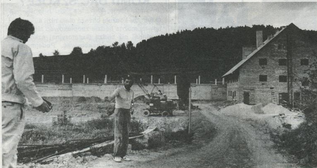
Budowa oczyszczalni ścieków - najważniejsza inwestycja w gminie.
