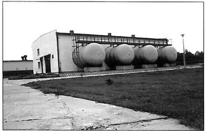
Stacja uzdatniania wody
