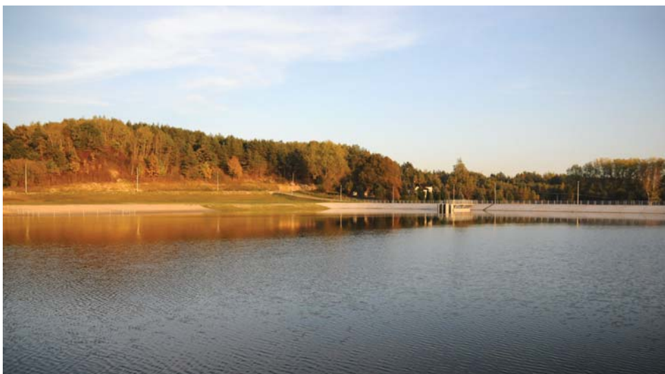
Zbiornik Małej Retencji na rzece Korzennej
