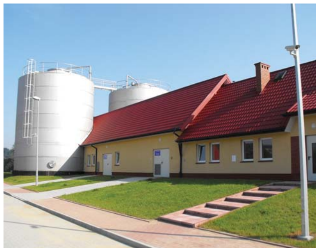
Oczyszczalnia ścieków w Bobowej
