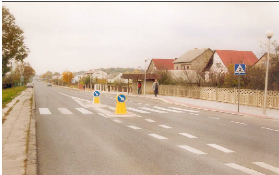
Fot.5 Zagospodarowanie drogi pogarszające brd: zła lokalizacja parkingu przed pocztą, fatalne prowadzenie ciągu pieszego i złe włączenia dróg bocznych
