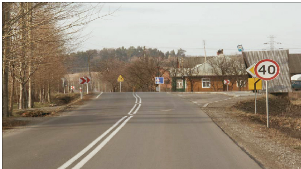
Fot.3. Zła widoczność na łuku i widoczność przejścia
